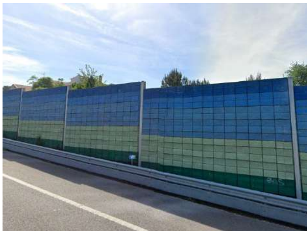
Figura 13: Barreira de Betão, localizada entre o km 93+760 e o km 93+872, no sentido crescente.
